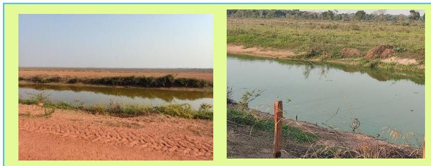
Figura 5.1.3-2: Canais de irrigação e drenagem do Projeto Rio Formoso
