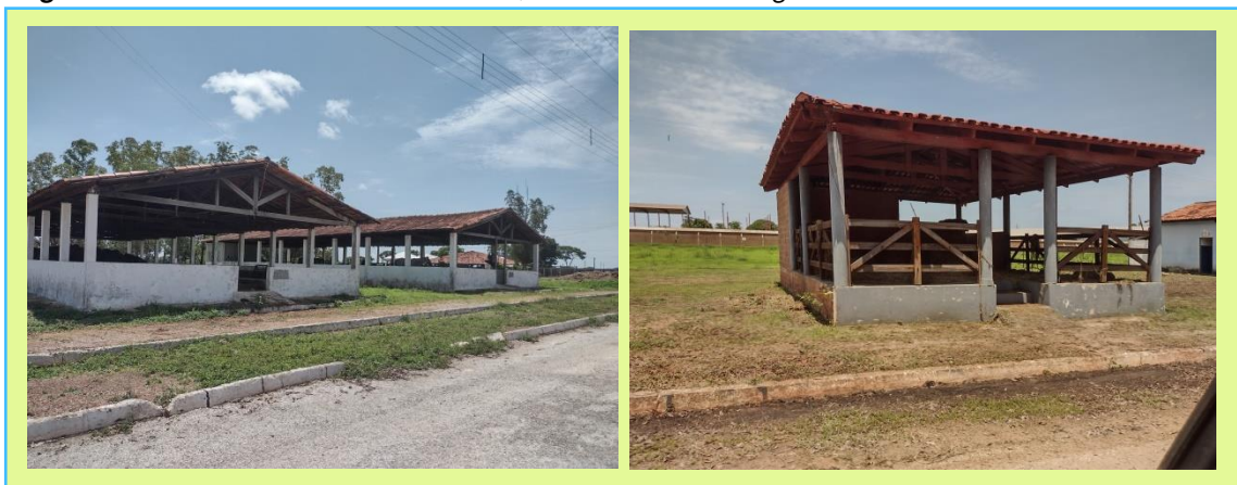
Figura 4.1.3-1: Recinto do Sindicato Rural, em Formoso do Araguaia
