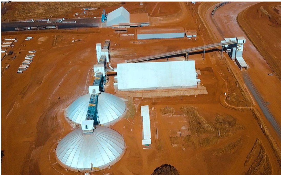
Figura 5 – Terminal Ferroviário localizado em Rio Verde/GO
